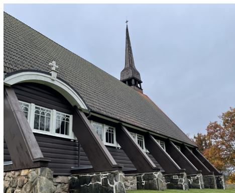
Konter-forten på Hindås kyrka är renoverade.
